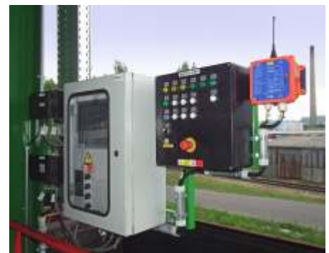
Obr. 3) Příklad uspořádání ovládací skřínky s dálkovým ovládním
